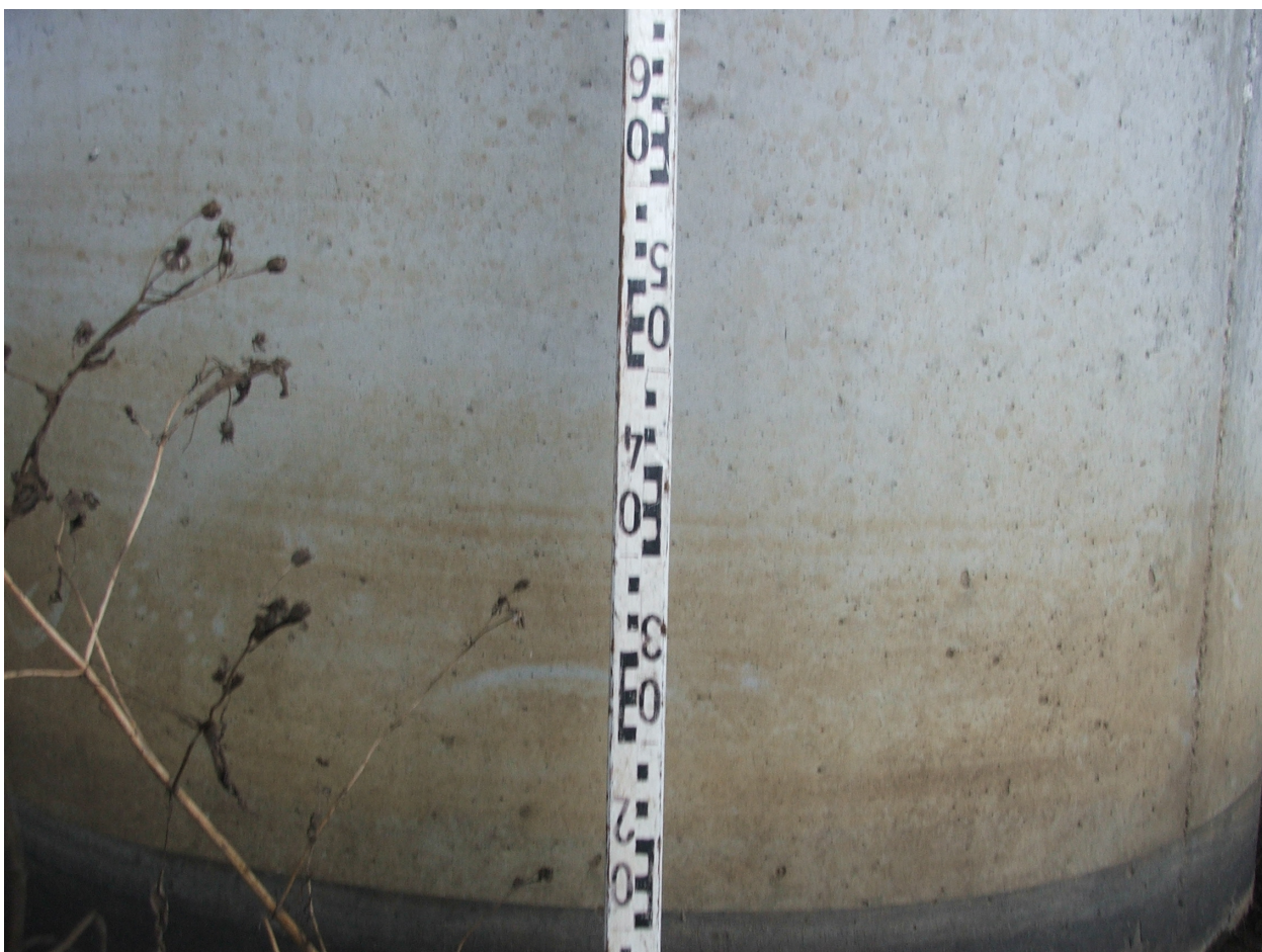
Fot.4 Ślady pokazujące wysokość zalania na filarach mostu do (fotografia własna 04.11.2024r).
